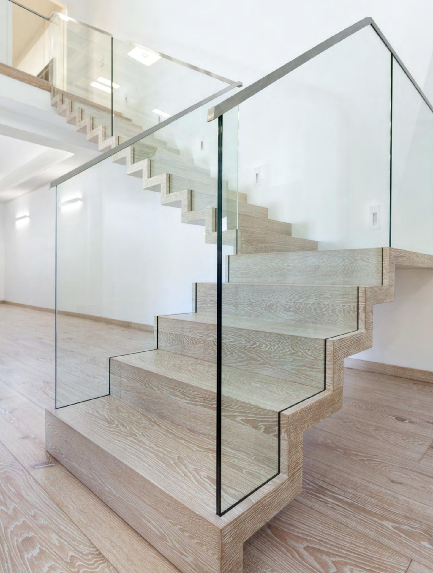
Konstruktion: Faltwerktreppe, zweiläufig mit Zwischenpodest
