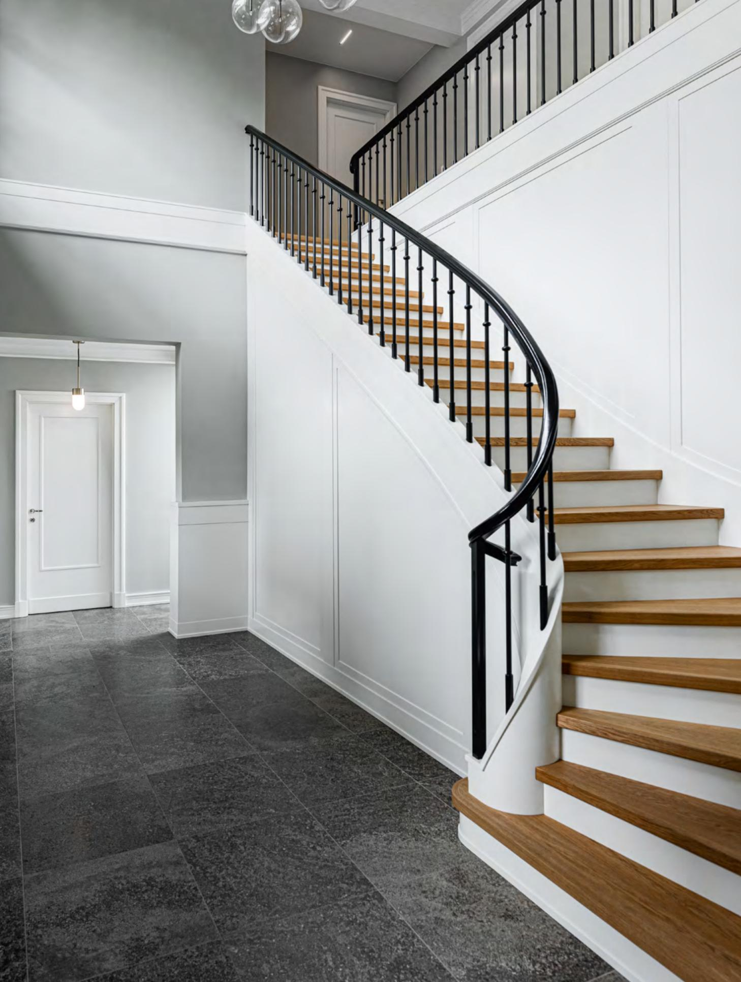
Konstruktion: Betontreppe mit Holzstufen,
