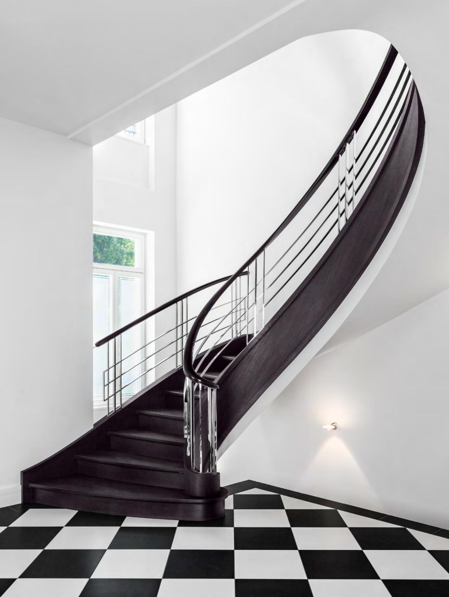
Konstruktion: Stahlbetontreppe mit Holzbelag
