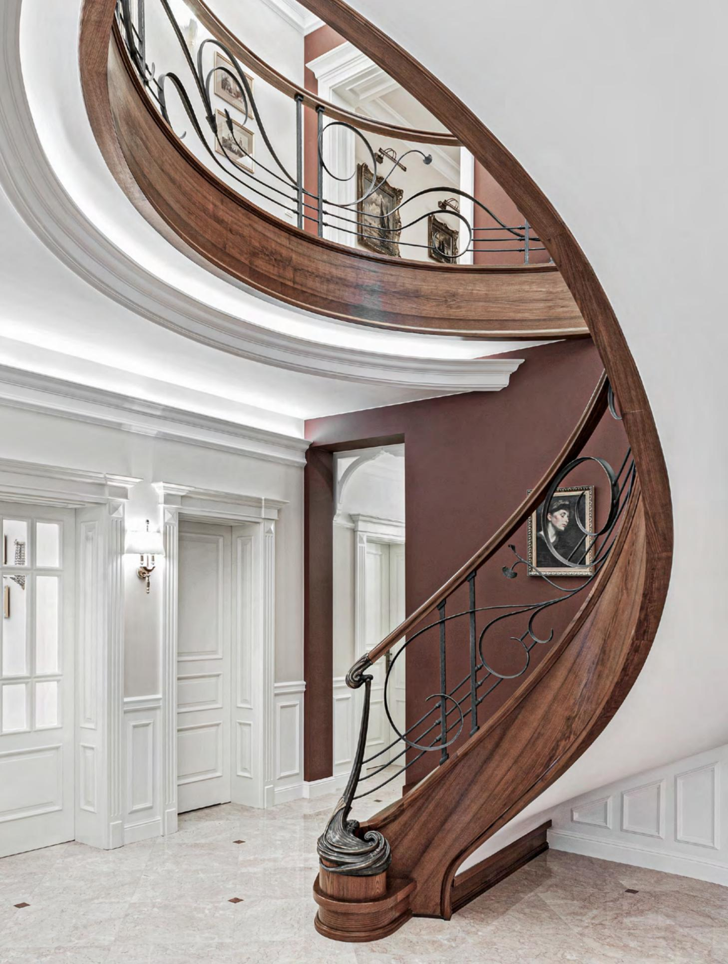
Konstruktion: Betontreppe mit Holzbelag, einläufig,
