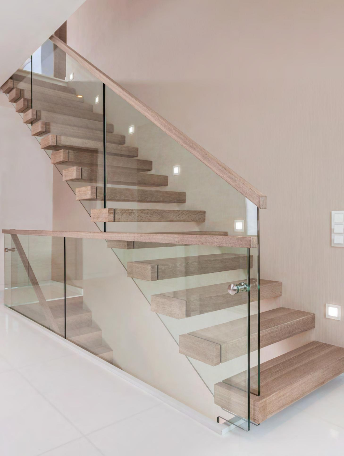
Konstruktion: Kragarmtreppe, einläufig
