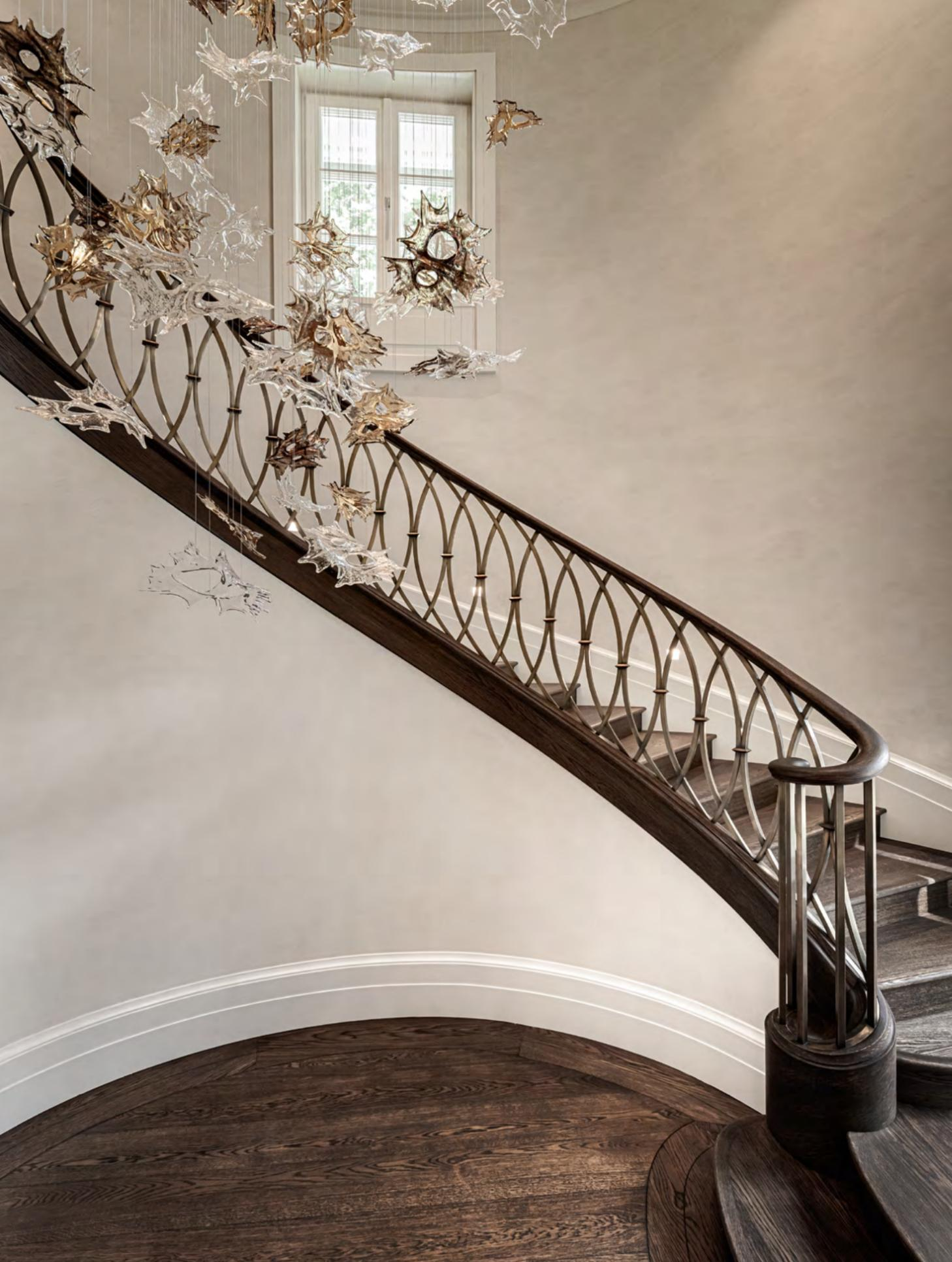
Konstruktion: Betontreppe mit Holzstufen
