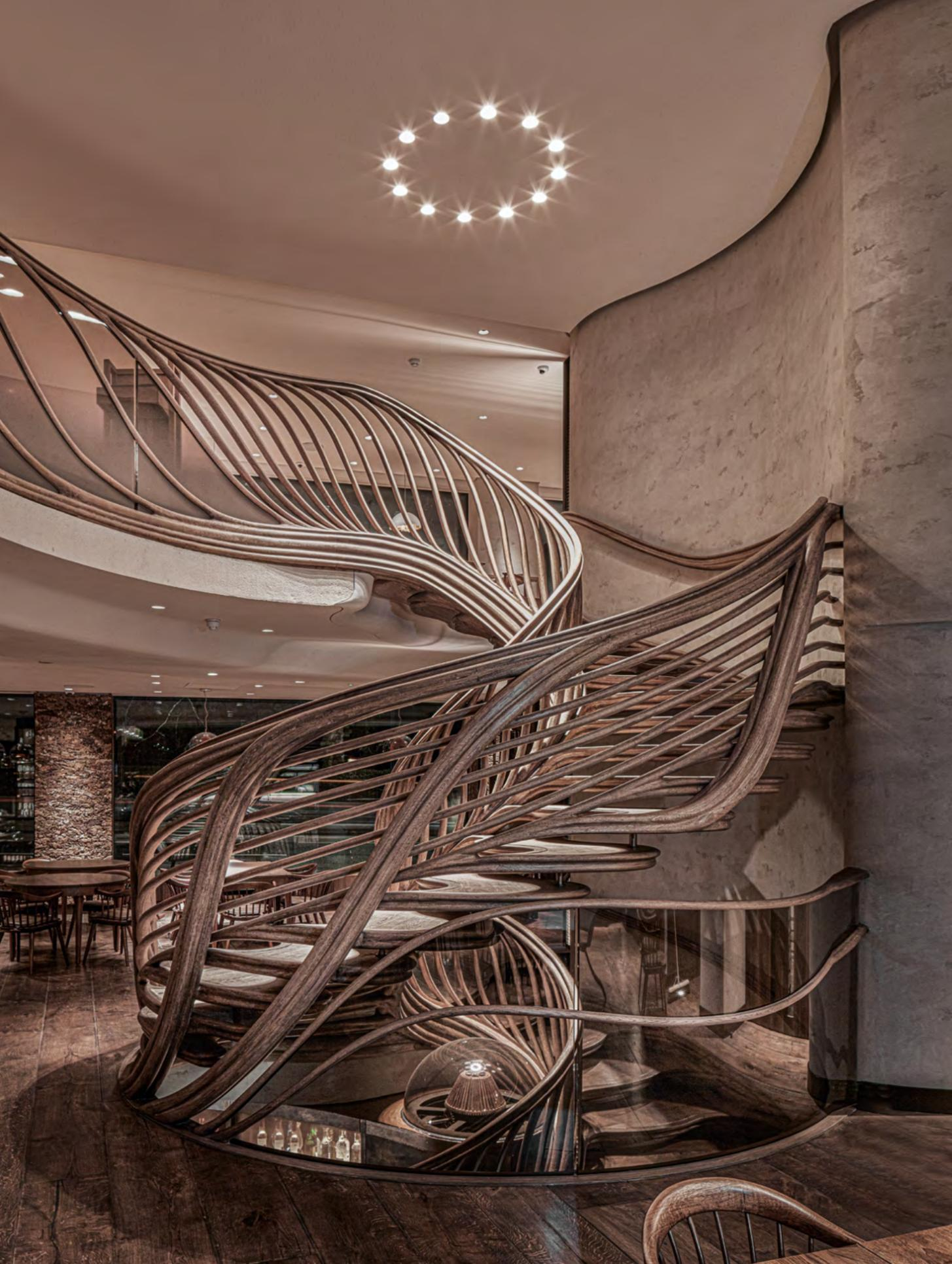
Konstruktion: Tragwerk aus Stahl mit Ummantelung aus Eichenholz. Diese organische Treppenanlage verbindet als geschnitzte Skulptur drei Geschosse in einer äußerst aufwendigen Geometrie.
