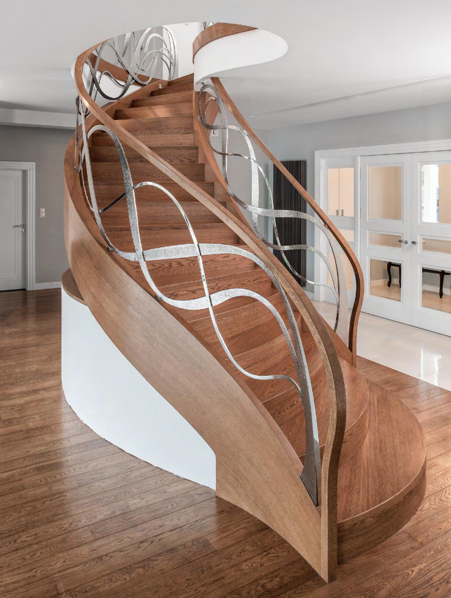
Konstruktion: Betontreppe mit Holzbelag, einläufig,
