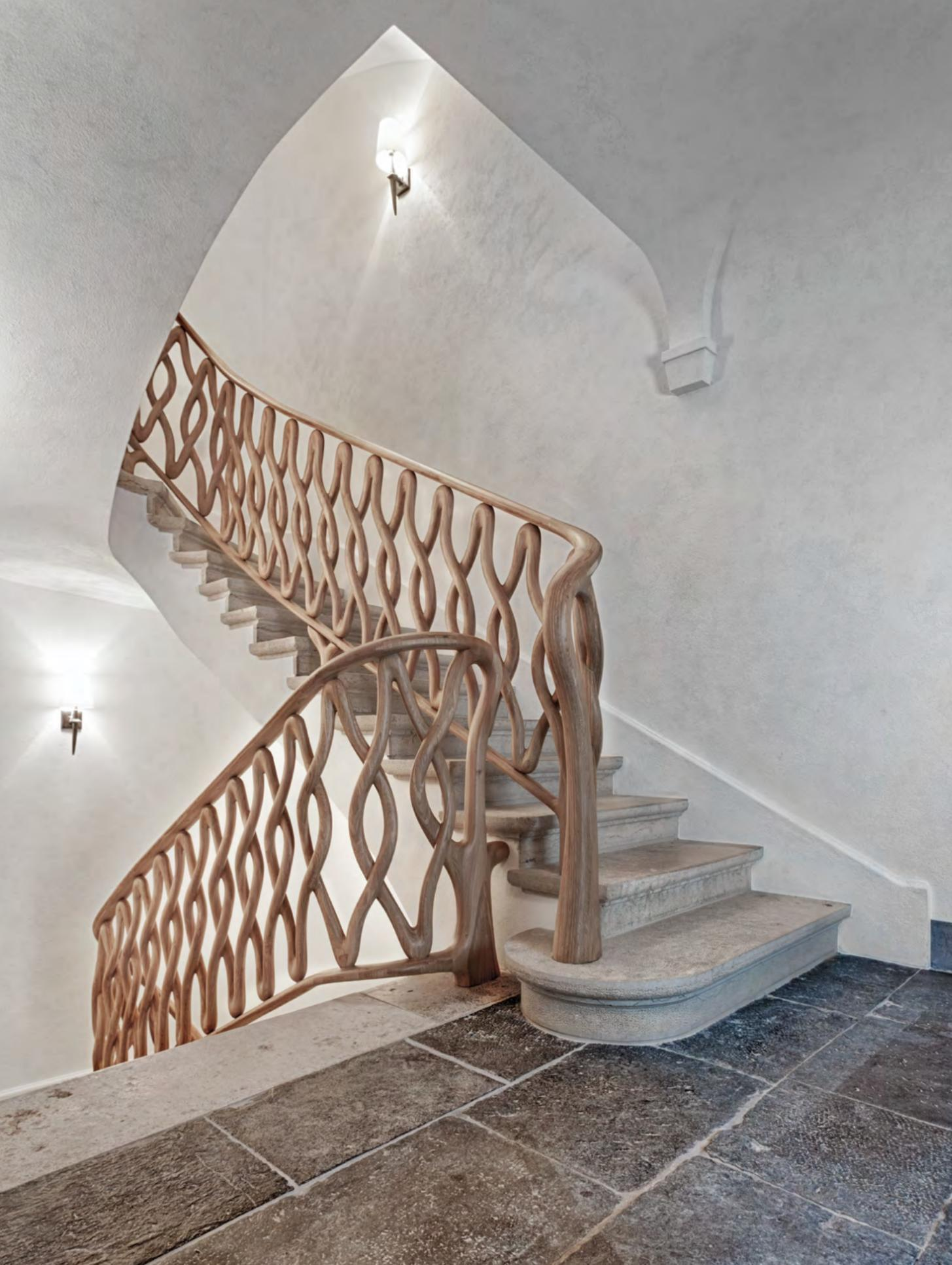
Konstruktion: Betontreppe mit Steinstufen, geschnitztes Holzgeländer über vier Geschosse
