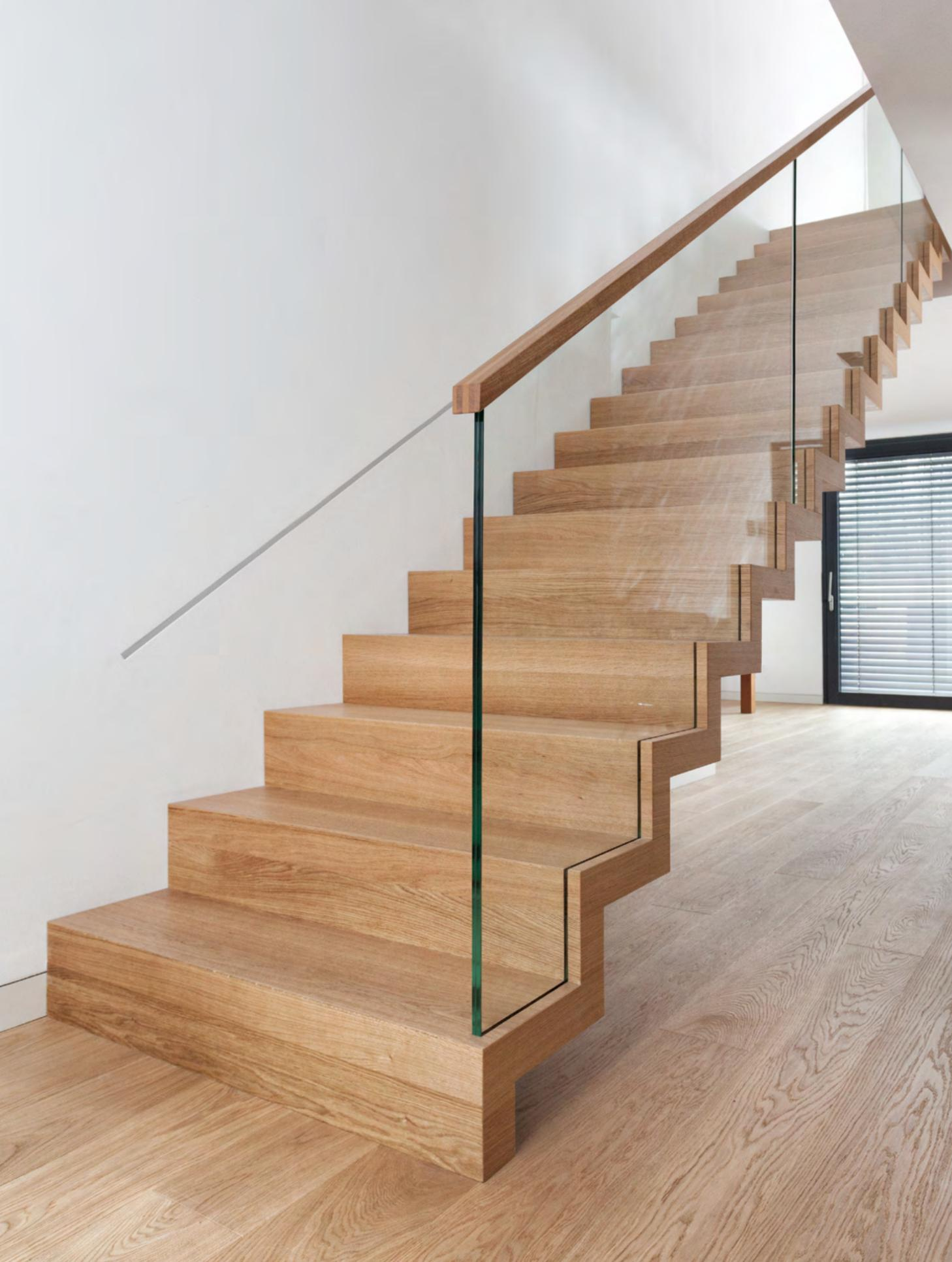
Konstruktion: Faltpulttreppe, einläufig
