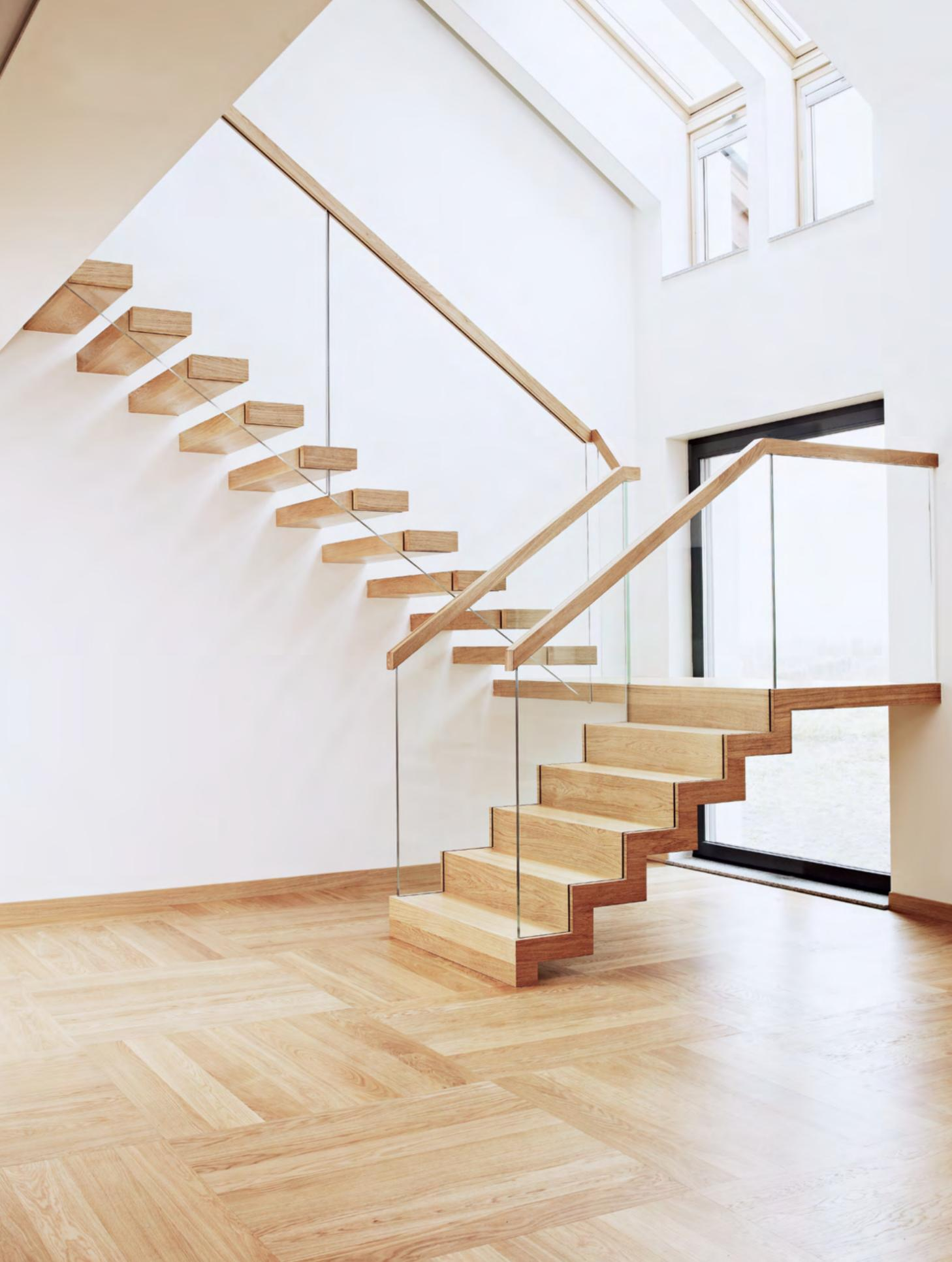
Konstruktion: Faltwerktreppe / Kragarmtreppe, zweiläufig mit
