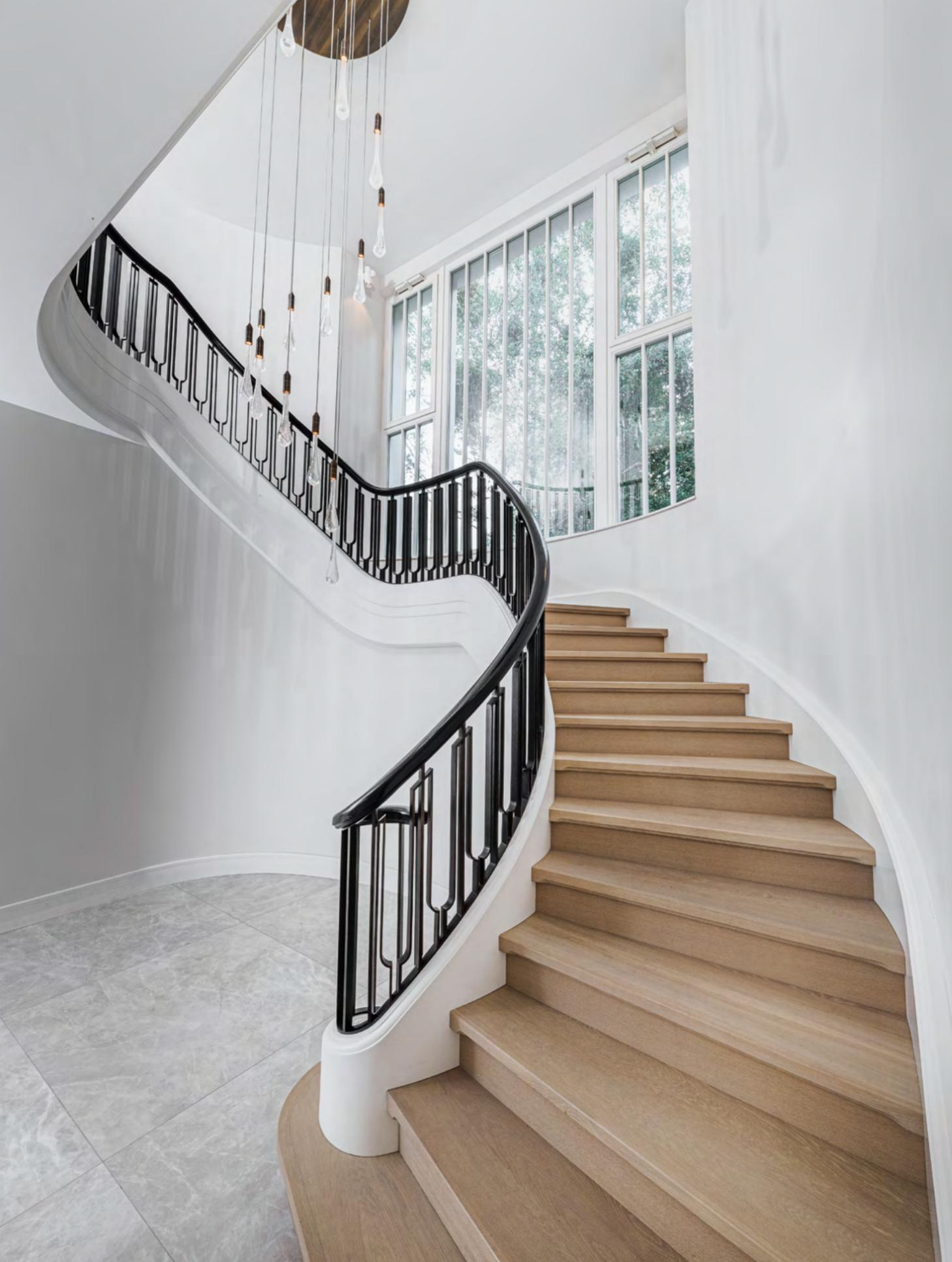
Konstruktion: Betontreppe mit Holzverkleidung, zweiläufig
